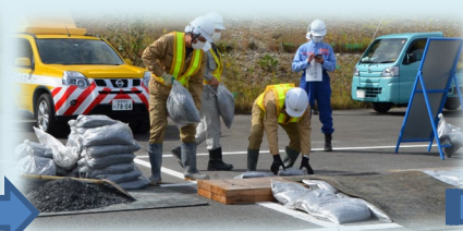
土嚢で段差解消
