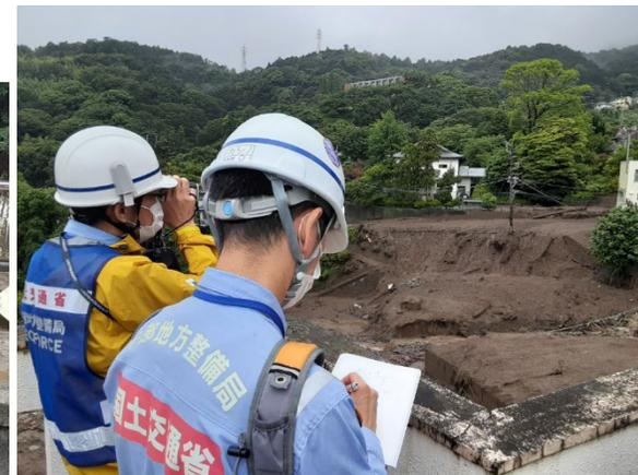
レーザー測距機による計測
