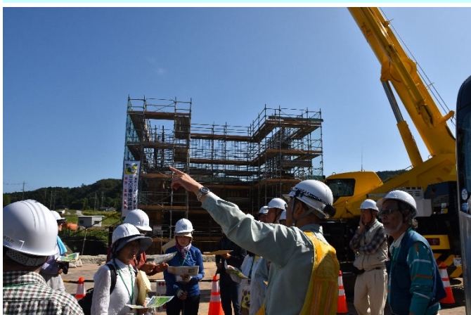
道路工事現場見学(瑞浪恵那道路)
