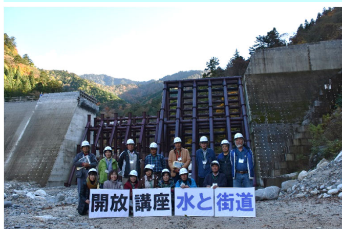
砂防工事現場見学(越百川第3砂防堰堤)
