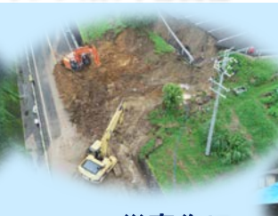
災害復旧 作業状況
