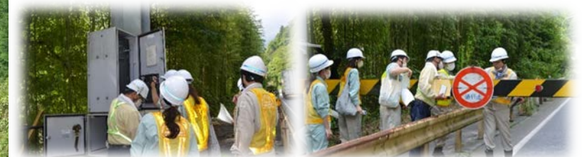
操作盤を開き、ブレーカーを「ON」に！
