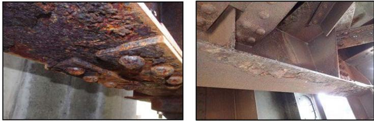
耐候性鋼材とは・・・表面に安定したさびができ、保護膜となり本体は腐食しない。塗装が不要でメンテナンスフリーと言われています。
