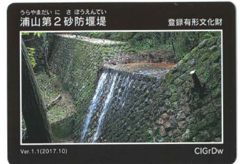
うらやまだいにさぼうえんてい 浦山第2砂防堰堤 (岐阜県土岐市妻木町)
