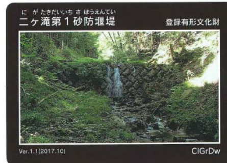
にがたきだいいちさぼうえんてい 二ヶ滝第1砂防堰堤 (岐阜県中津川市川上)
