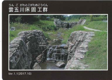
うんごがわとこがためこうぐん 雲五川床固工群 (岐阜県土岐市上肥田)
