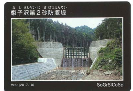
なしざわだいにさぼうえんてい 梨子沢第2砂防堰堤 (長野県木曾郡南木曾町)
