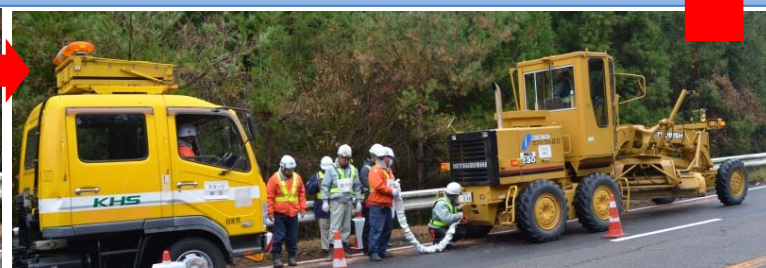
スタック車両とけん引車両にけん引ロープ設置
