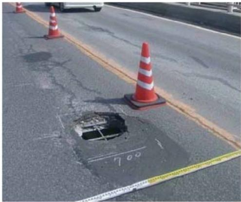
コンクリートの床版が抜け落ち、舗装に空いた穴
