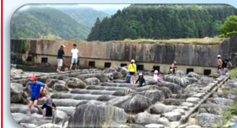
湯舟沢床固工で魚道の見学をしました
