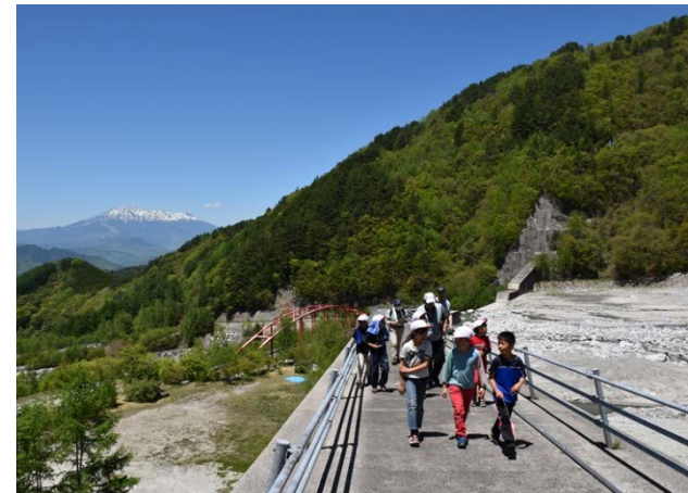
砂防堰堤の天端から堆積物を見学しました。
