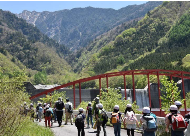
橋の奥に見えるのが滑川第一砂防堰堤です。
