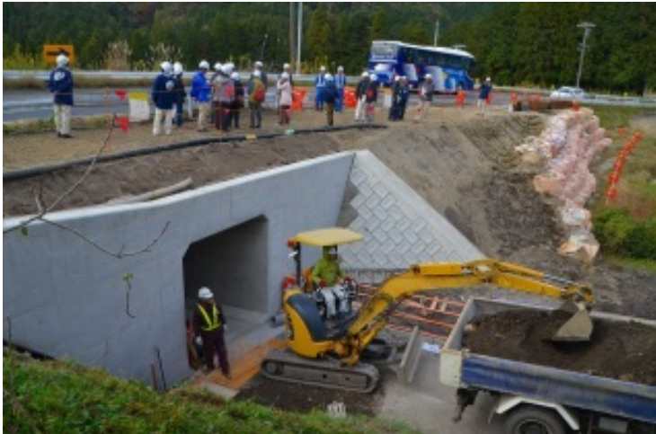
道路現場見学(山口道路改良工事現場)
