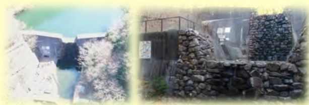
深山谷第1砂防堰堤(多治見市笠原町)
