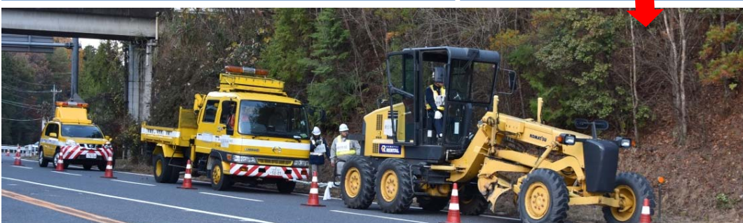
スタック車両移動訓練の様子（グレーダーが真ん中のスタック車両を牽引中）
