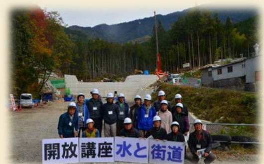
梨子沢災害復旧現場にて
