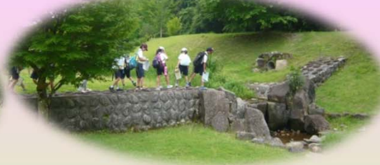
雲五川床固工で帯工を見学
