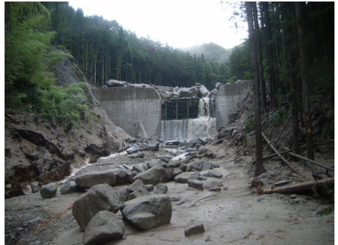
梨子沢第 2 砂防堰堤（国交省）【大梨子沢】
