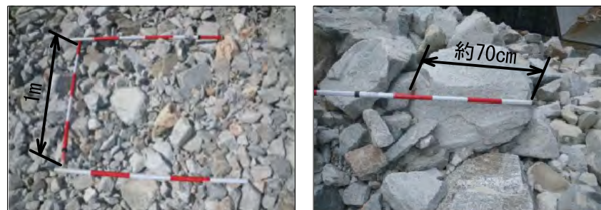
台風18号で本谷第10砂防堰堤に貯まった土砂
