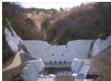
不透過型砂防堰堤 (本谷第10砂防堰堤) 落合川流域
