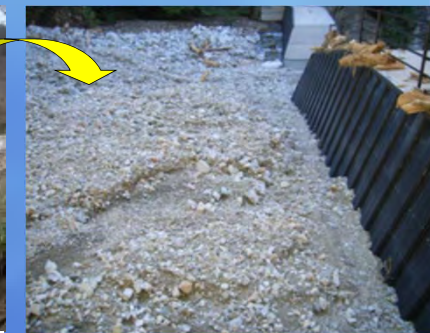
土砂捕捉状況 (平成25年9月17日)
