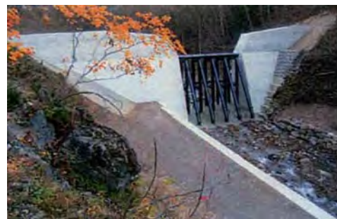
網製スリット砂防堰堤 (丸山沢第1砂防堰堤) 木曾川残流域
