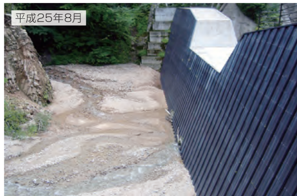
本谷第10砂防堰堤 (中津川市)
