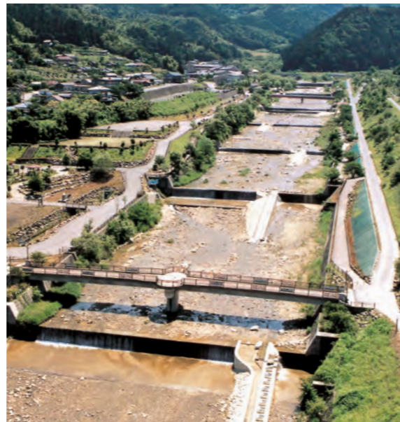
トンネル式魚道の内部 幅の広いものとトンネル式の ふたつの魚道がある12号床固工
