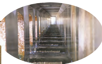
トンネル式魚道の内部 幅の広いものとトンネル式の ふたつの魚道がある12号床固工
