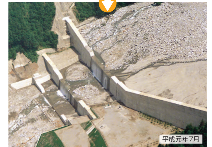
土石流を貯めたあとの滑川第1砂防堰堤
