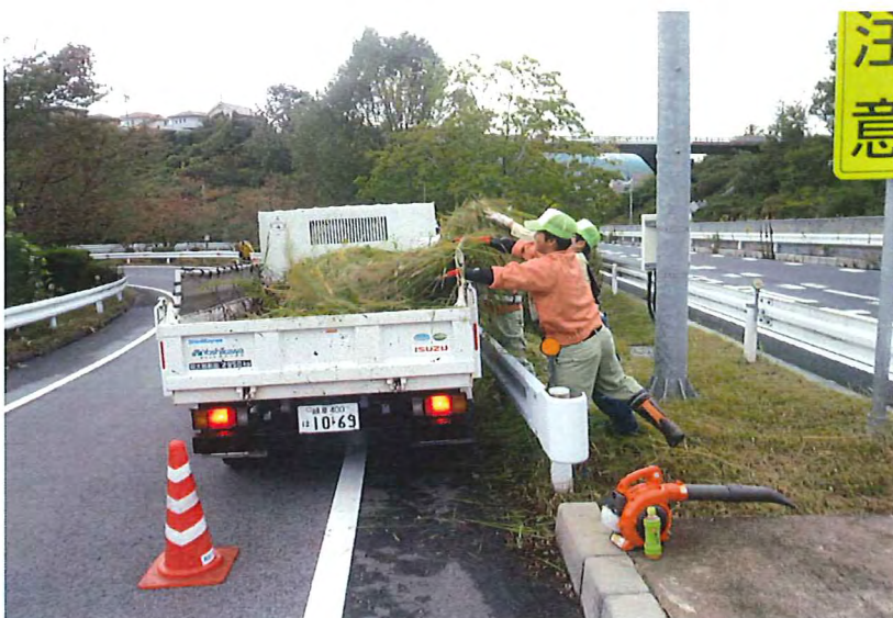
除草積み込み作業
