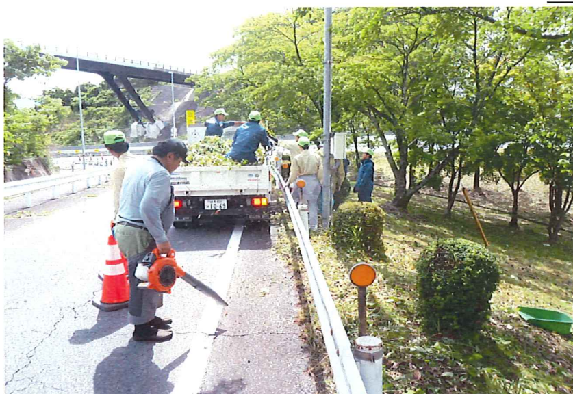
除草積み込み作業
