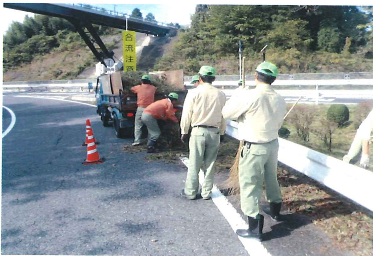
除草積み込み作業
