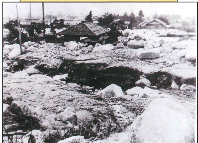
土砂に埋没した家々 写真一②
