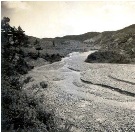
土えん堤上流の地形状況 (西之洞第1砂防ダム)
