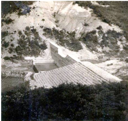
土えん堤竣工後の状況 (溝洞第1砂防ダム;昭和27年5月10日)
