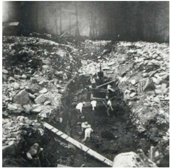
基礎掘削状況
