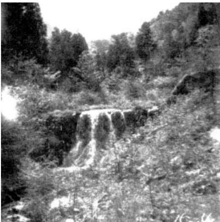
空石積えん堤 (下平次第1砂防ダム;昭和23年5月竣工)
