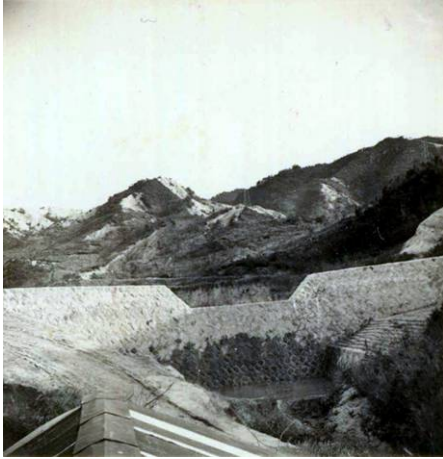
練石積えん堤 (大平第1砂防ダム;昭和27年5月1日)
