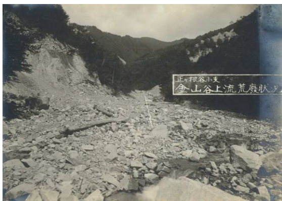
中津川上流域の荒廃状況 (正ヶ根谷・金山谷の崩壊状況)
