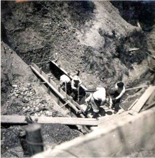
コンクリート搗固状況 (一ノ洞第1砂防ダム;昭和28年4月28日) スコップなどを用いてコンクリートを搗き固める。
