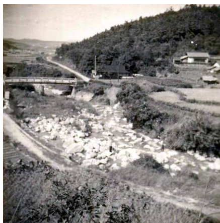
花崗岩類分布域の河床状況 (大滝第3床固:昭和27年11月) 堤体材料となる巨石が多く転在する。
