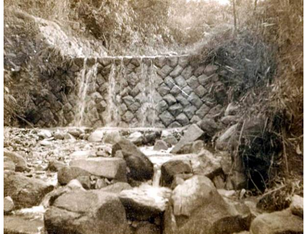
空石積えん堤 (浦山第1砂防ダム;昭和17年8月24日竣工)
