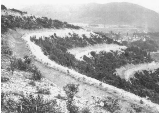
等高線壊工法 (団子山山腹工;昭和28年2月竣工)
