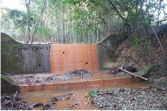
丸味を帯びた水通しを有する砂防えん堤 (左:脇之島第1砂防ダム;現存せず、右:杉流第1砂防ダム)
