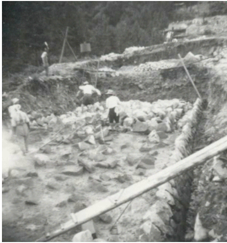
練石積えん堤における中埋め石の設置状況 (木曾川流域)
