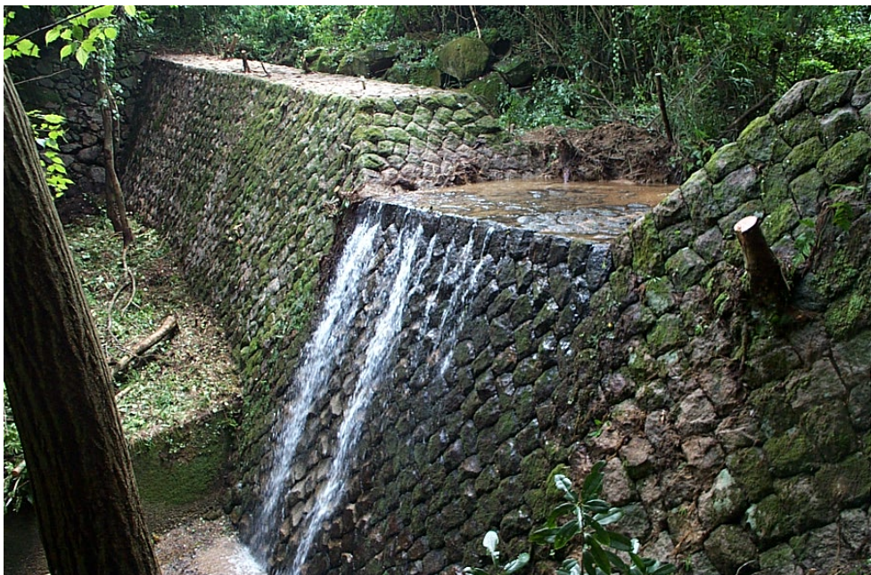
浦山第2砂防ダム(土岐市妻木町)
