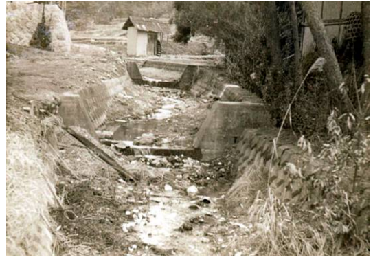
床固・流路工 (鳥屋水路;昭和17年2月竣工)
