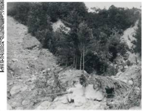
山腹崩壊(杉流)
