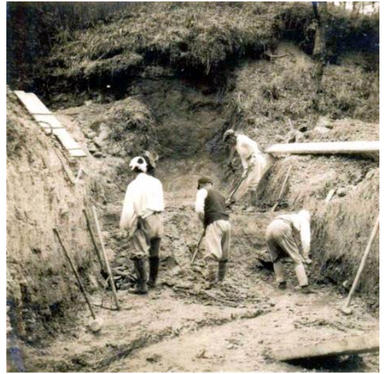
基礎掘削状況
