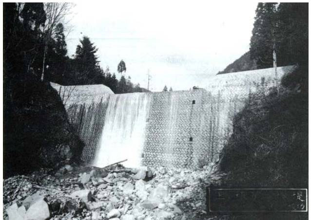
練石積えん堤 (正ヶ根第2砂防ダム;昭和29年3月竣工)
