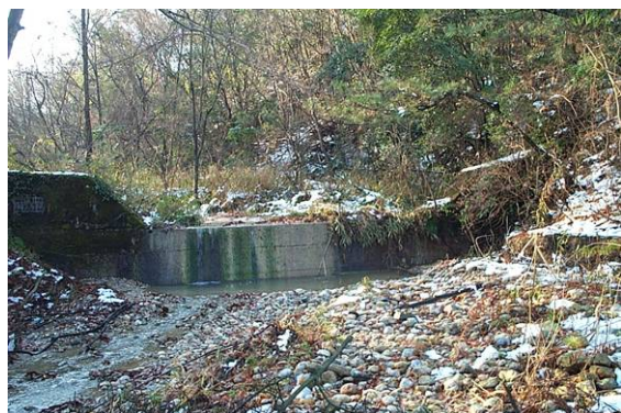
赤坂第2砂防ダム (コンクリートえん堤; 土岐川流域)
