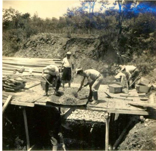
コンクリート練り混ぜ状況 (鍛冶ヶ入第2砂防ダム;昭和27年6月15日) 鉄板上における手練りである。
