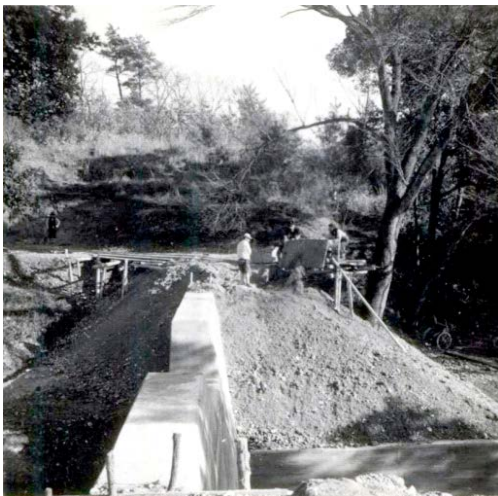
盛土状況(鍛冶ヶ入第2砂防ダム;昭和27年10月25日)
