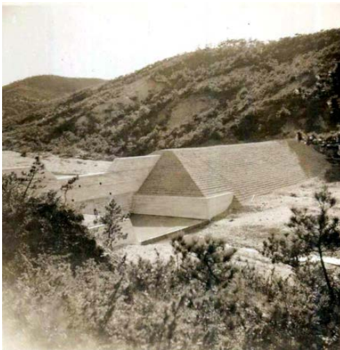
土えん堤(コンクリート水路付) (西之洞第2砂防ダム;昭和28年1月14日竣工)
