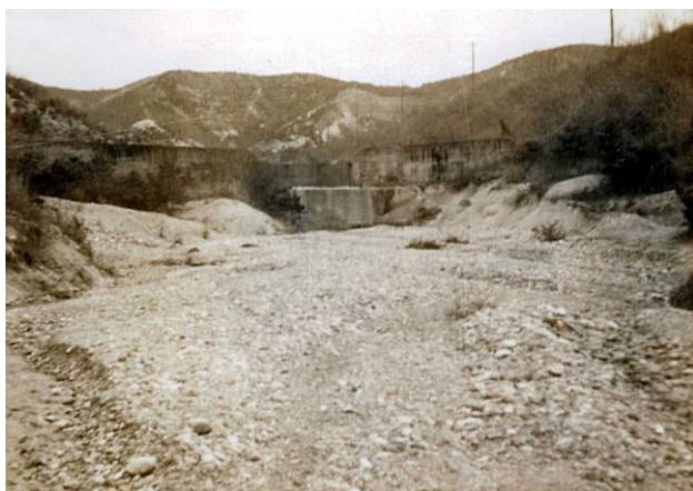
土岐砂礫層分布域の河床状況 (日帰第1砂防ダム) 積石に使用できるような大きな転石はみられない。
