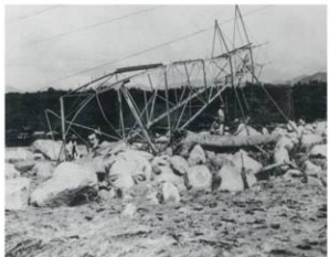
倒壊した鉄塔(下実戸)
