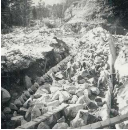
練石積えん堤の中埋め石の設置 右)三又を用いた中埋め石の運搬 左)中埋め石の配置状況、
