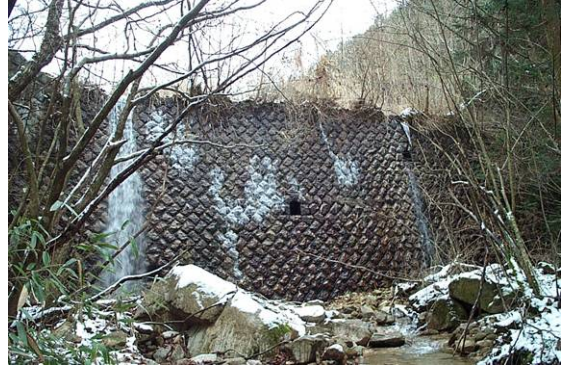
丸味を帯びた水通しを有する砂防えん堤 (左:脇之島第1砂防ダム;現存せず、右:杉流第1砂防ダム)
