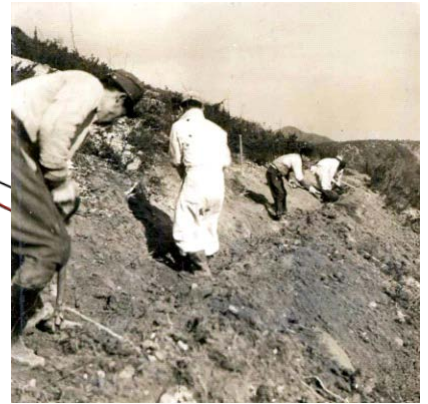
人力による壕の掘削状況
