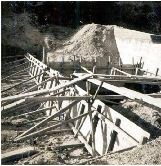
型枠組立状況
