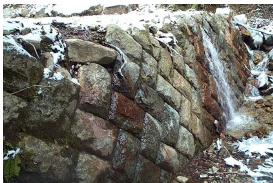
二ヶ滝第1砂防ダム (空石積えん堤; 木曾川流域)
