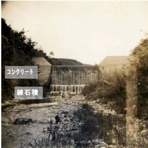
基部が練石積/上部がコンクリートえん堤 (生田第1砂防ダム;昭和27年5月竣工)
