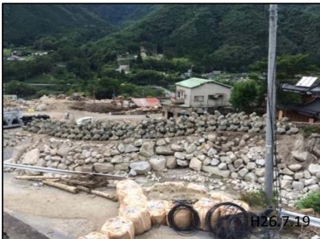
巨石積み護岸及び根固ブロック設置状況
