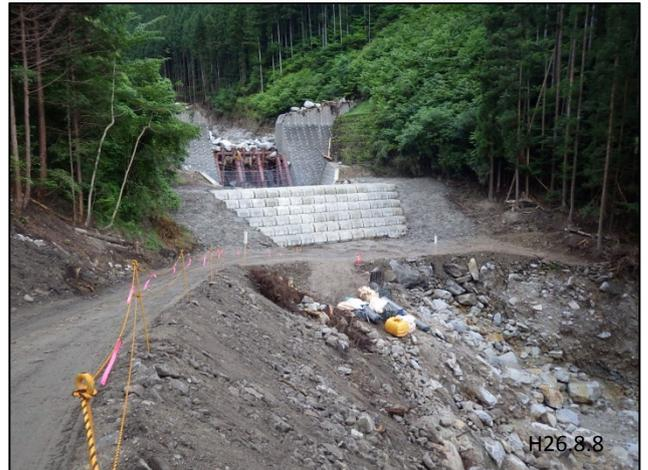
ブロック堰堤設置状況(梨子沢第1砂防えん堤直下)
