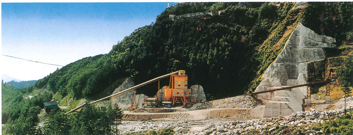
施工機械及び設備
