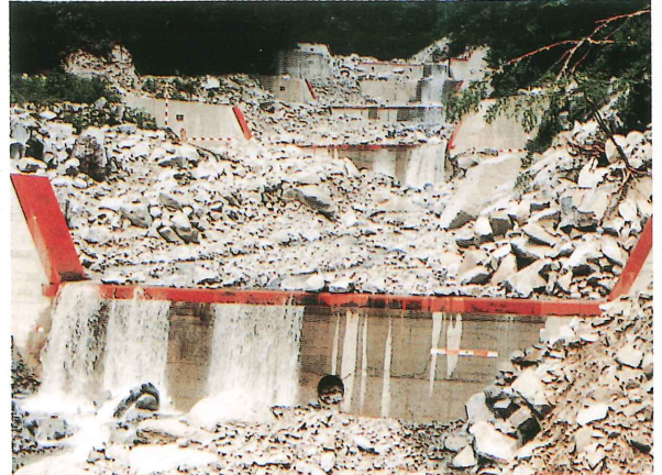
カメラ設置位置より上流域を望む
