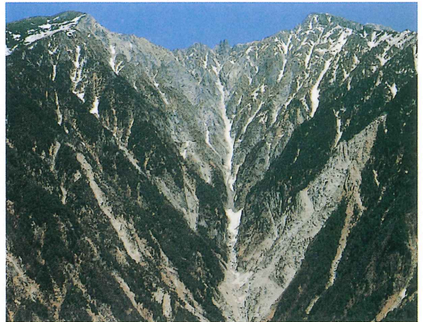
滑川上流域崩壊状況
