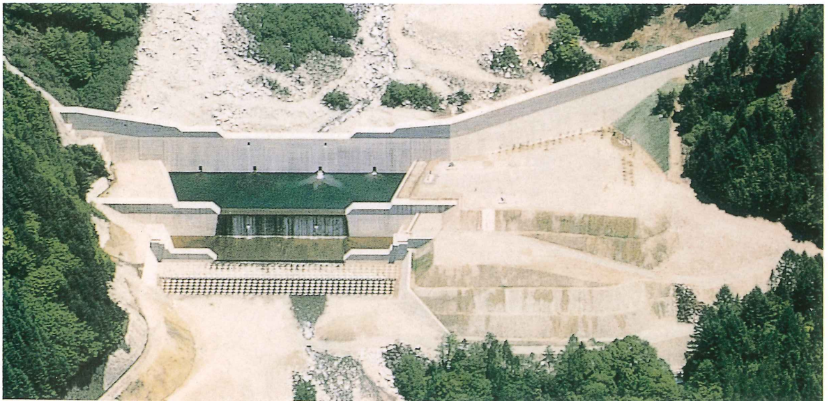
滑川第1砂防ダム完成写真
