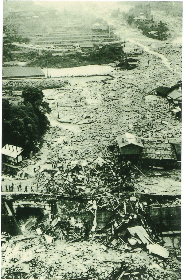
昭和41年6月南木曾災害での土石流による被害 (手前は木曾川及び国道19号、国鉄中央線)
