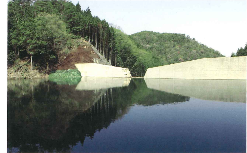
■堰堤上流 完成したばかりは水が貯まっていますが土石流が発生した場合はこの水と同じくらの土砂を貯め下流域を守ります。
