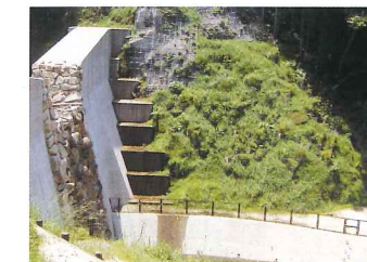
■堰堤上流 完成したばかりは水が貯まっていますが土石流が発生した場合はこの水と同じくらの土砂を貯め下流域を守ります。
