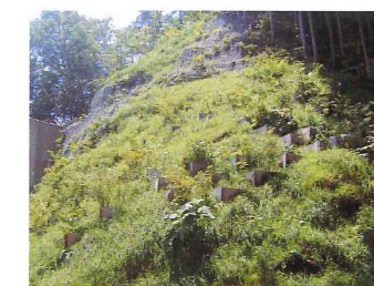
■法面緑化 掘削後の法面処理方法に古紙等をリサイクルしてつくられた「分解性木質ボード」を使用しています。この素材は施工後5～10年程度で分解され土に戻ります。
