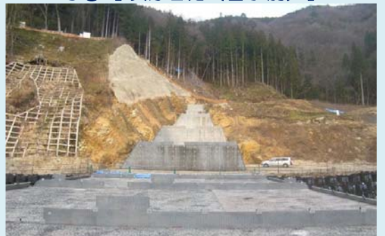
写②【砂防堰堤（着手前）】
