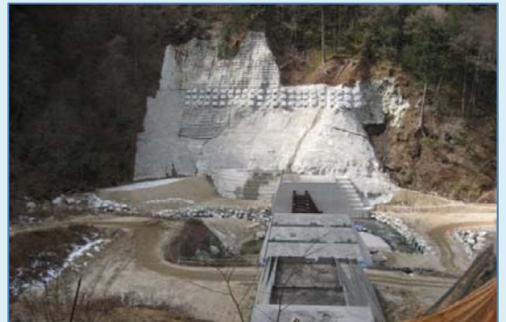
写①【砂防堰堤（着手前）】
