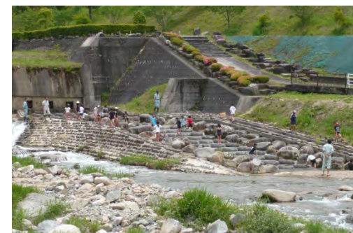
湯舟沢床固工群での様子
