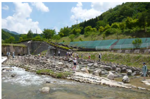
湯舟沢床固工群での様子
