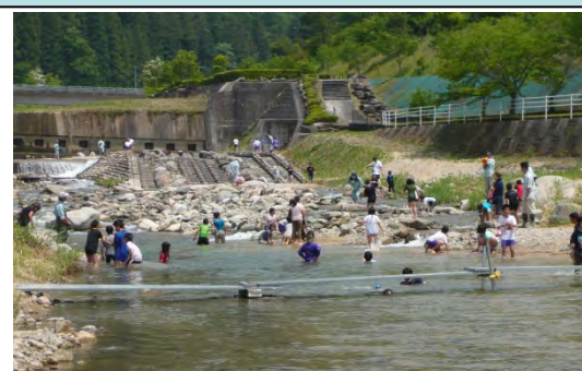
湯舟沢床固工群での様子
