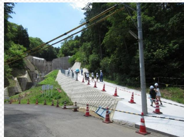
砂防堰堤の現場見学をしました
