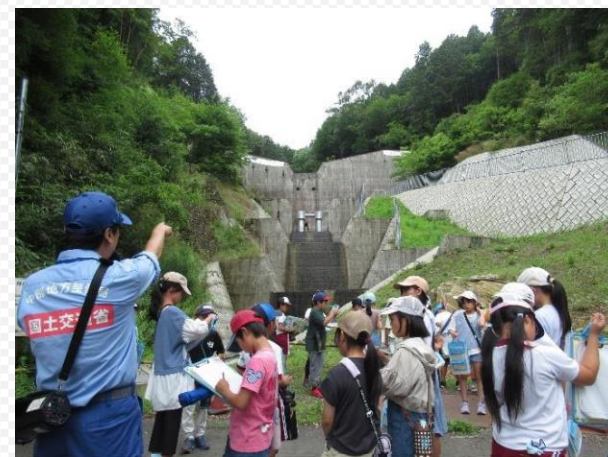
砂防堰堤の現場見学をしました
