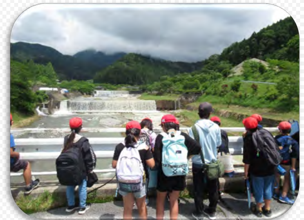
床固工と魚道の役割を学びました
