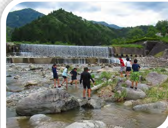
床固工と魚道の役割を学びました
