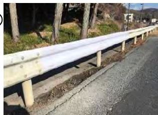
19号58.870km(下) 損傷復旧工
