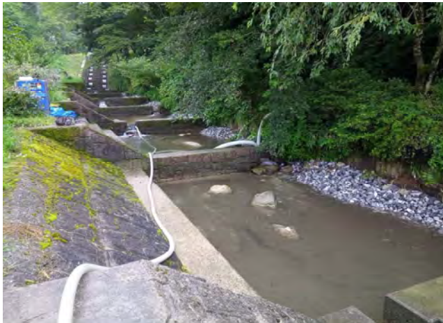
堀切川流路整備
