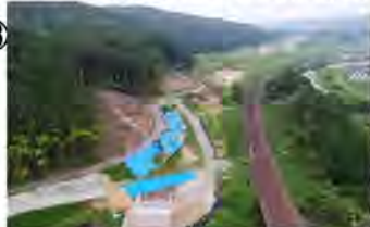
道路土工(掘削工)
