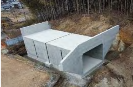
カルバート工(2-18号横断函渠)
