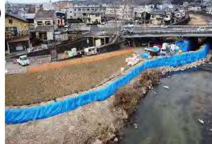
橋脚巻立て工
