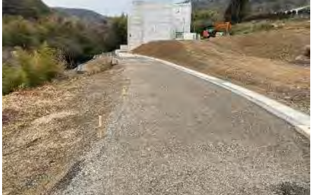
下層路盤工(機能補償道路)
