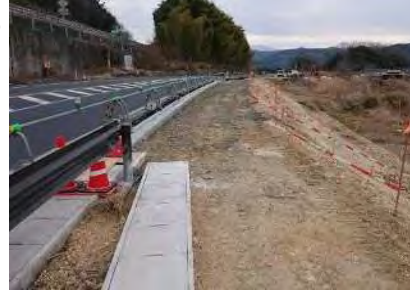
道路土工・掘削
