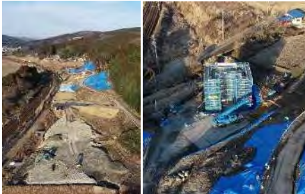
A1橋台工・排水構造物工
