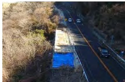
地山補強土工(2号)
