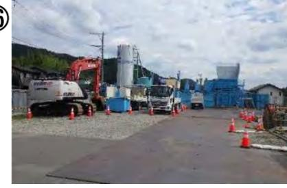
充填孔設置工、充填到達観測孔設置工、車上プラント組立
