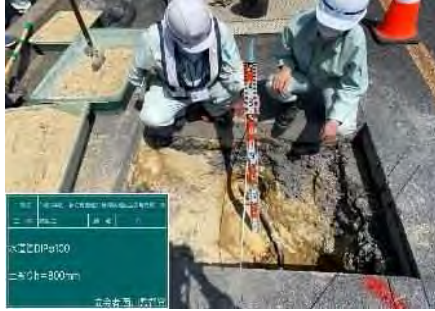
準備工(水道管試掘、削孔計画)
