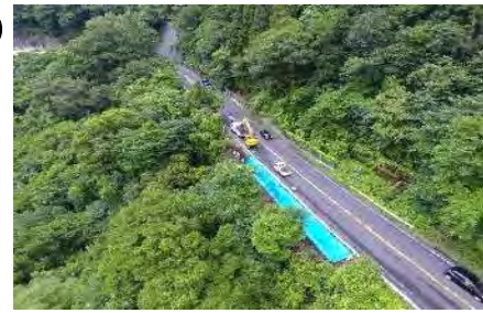
準備工・補強地山土工
