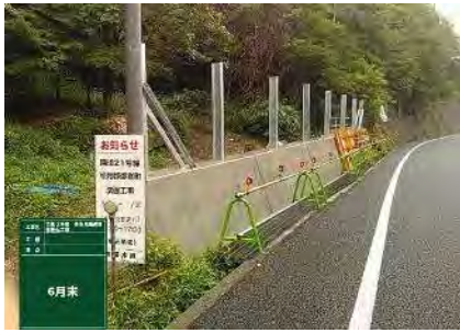
擁壁工、落石防止工
