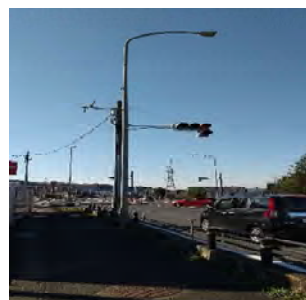
道路照明設備工
