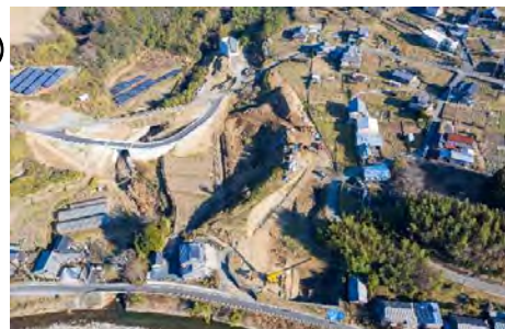
P4橋脚 床掘・切土補強
