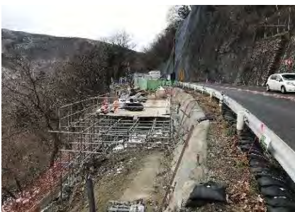
地山補強土工
