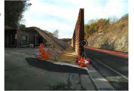
道路土工、法面保護工
