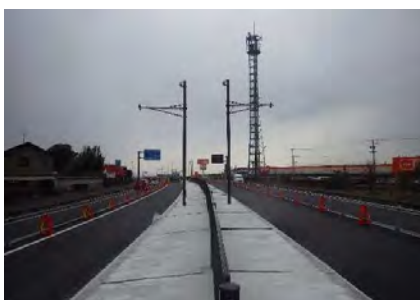
舗装工、排水構造物工、縁石工
