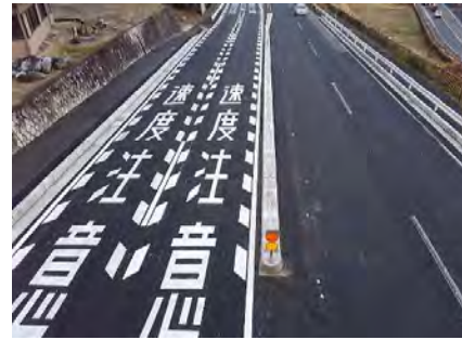
排水構造物工他 土岐工区
