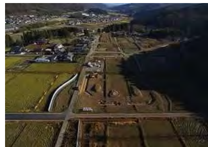
切廻し道路、排水構造物工
