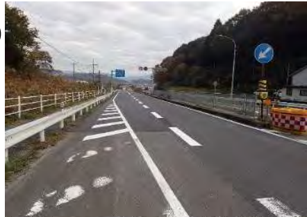
田邊橋 橋梁付属物工
