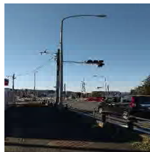
道路照明設備工
