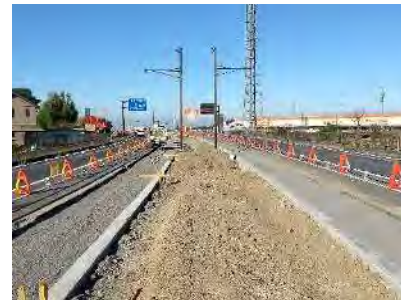
舗装工、排水構造物工、縁石工
