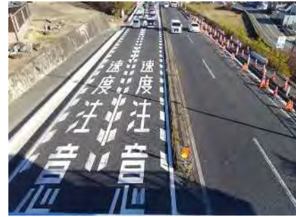
排水構造物工他 土岐工区
