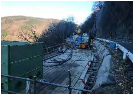
地山補強土工
