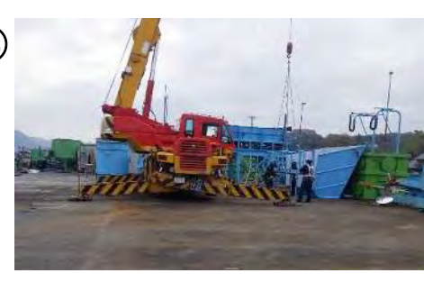
プラント解体作業
