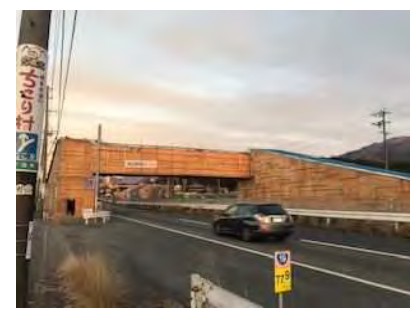
中津川工区 千旦林横断歩道橋塗装工
