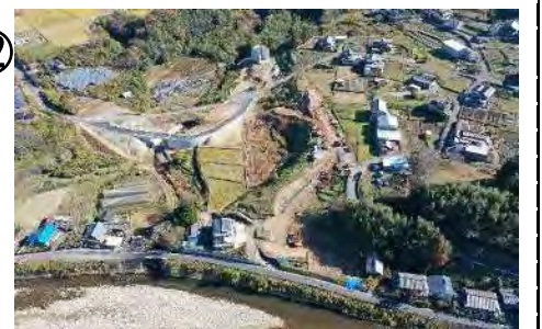
P4橋脚 床掘・切土補強
