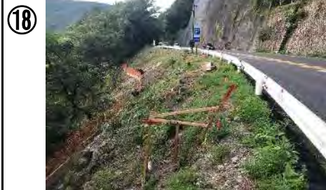
令和元年度多治見国道中津川地区整備工事
