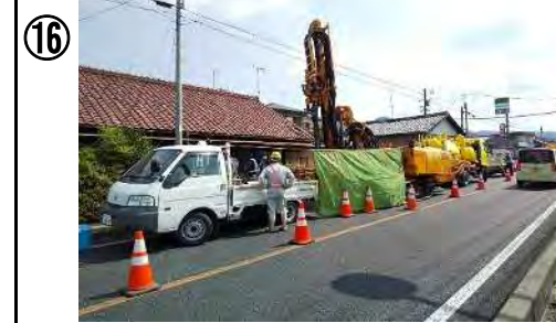
令和元年度多治見国道21号中畑地区垂坑充填工事
