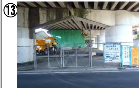
令和元年度多治見国道管内橋梁補修工事
