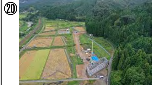
令和元年度瑞浪恵那道路公文垣地区道路建設工事
