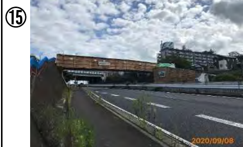
令和元年度多治見国道東部横断歩道橋塗装工事
