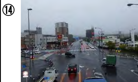
令和元年度多治見国道多治見土岐地区整備工事
