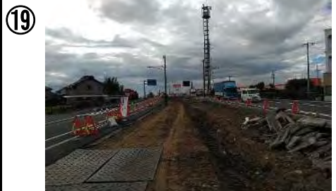
令和元年度多治見管内改築舗装工事
