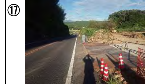
令和元年度多治見国道瑞浪地区整備工事
