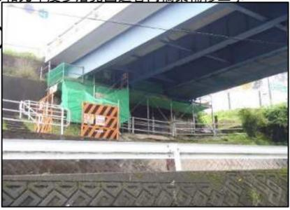
大洞橋 橋梁補修工 鋼桁工 橋梁支承工
