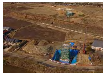
P3橋脚 鉄筋・型枠組立
