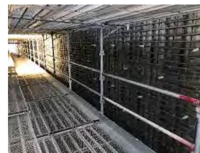
橋脚巻立工(鉄筋工)
