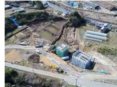
滝沢川橋A2:橋台躯体工・排水構造物工
