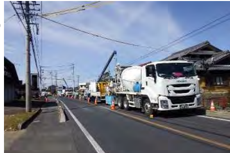
充填孔設置工、充填工
