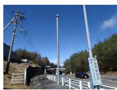
CCTV設備工(次月交差点) HD簡易型IPカメラ設置
