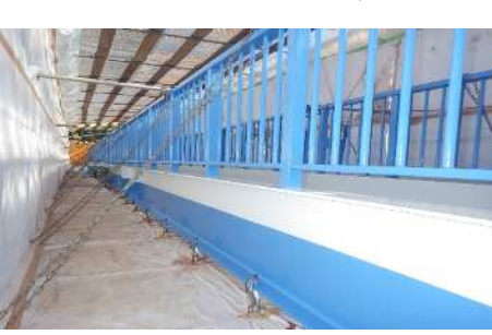
東町横断歩道橋(防食塗装完了)
