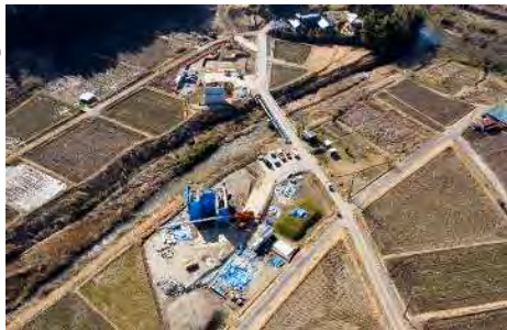
A2橋台 躯体施工中 用水付替工 施工中
