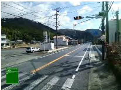
御嵩3工区 御嵩町中切地内(舗装工 区画線工)
