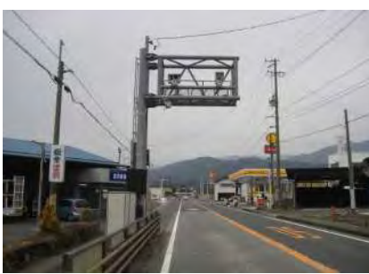
無停電電源設備設置工(山口下り)
