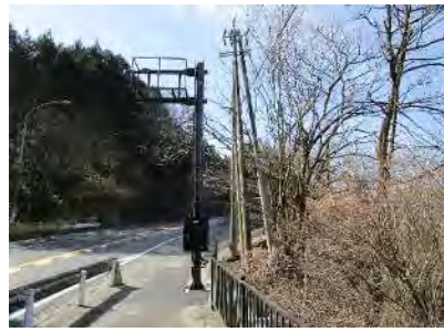
CCTV設備工 CCTVカメラ設置
