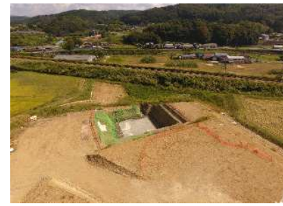
A1橋台 床掘り・均しコンクリート
