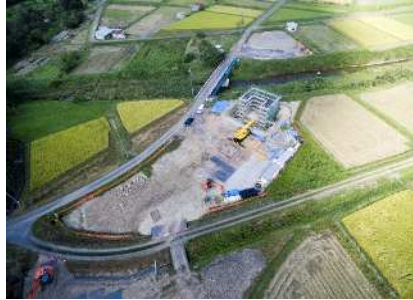
A1橋台 躯体工事中
