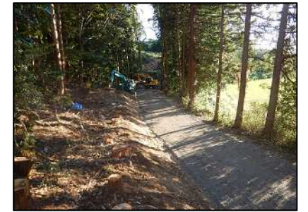
伐採工・路盤工 No.135付近造成地
