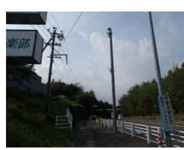
準備工 (CCTV設備 次月交差点 R21-7.480kp)
