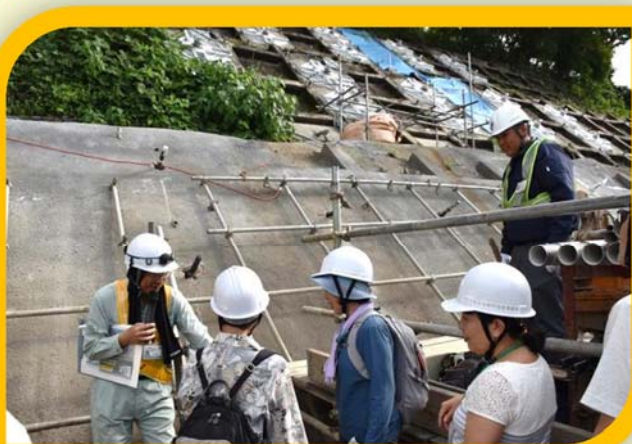
斜面の崩壊を防ぐ対策工事(アンカー工)の現場を見学しました。
